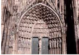
Strasbourg, cathédrale : le portail central de la façade occidentale
