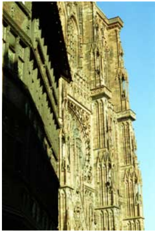
La façade occidentale et la maison Kammerzell
